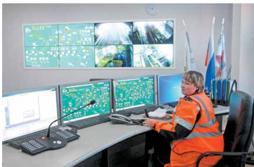
Диспетчерский пункт модуля позволяет оперативно контролировать всю технологическую цепочку обогащения угля
